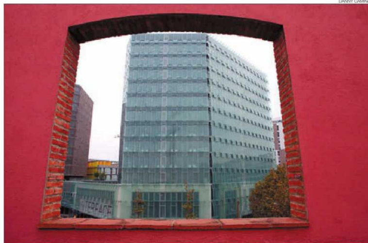
► El nou edifici, amb l'antiga faana de la Netol ara envidriada formant-ne la base, ahir.
