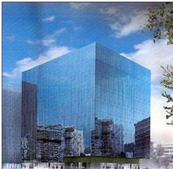
CASTELLVÍ INICIA LA SEGUNDA FASE DE CONSTRUCCIÓN DEL 22@BUSINESS PARK 08/06/2010
